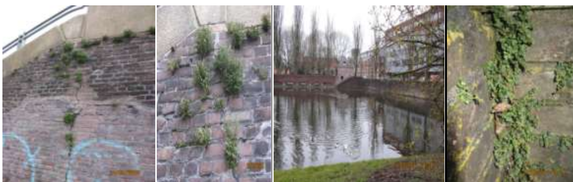
Figuur 12. Links: Doorlopende hoge keermuur bij het viaduct (type d, fig. 9), Hereweg, overzicht en detail. Rechts: Doorlopende hoge keermuur bij stadsvijver (type e, fig. 9), Linnaeusplein, overzicht en detail.
