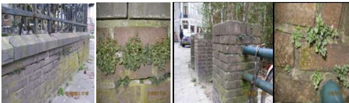
Figuur 11. Links: Doorlopende lage afscheidingsmuur (type b, fig. 9), Bloemsingel. Rechts: Onderbroken lage afscheidingsmuren verbonden door metalen buizen (type c, fig. 9), Melkweg.
