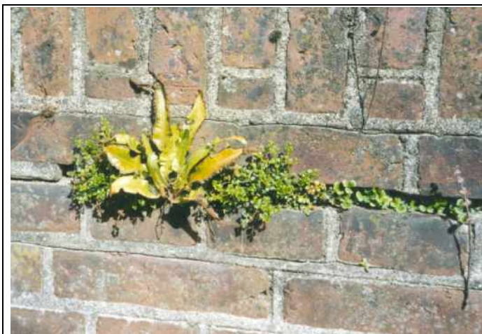
Vestiging van Tongvaren en Muurvaren op kademuur, duidelijk is te zien dat vestiging heeft plaatsgevonden in de ontbrekende voeg (Foto Beb de Haas, Norg).
